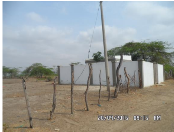
Muro de cerramiento del área donde se encuentra la caseta de bomba, la cual fue intervenida
