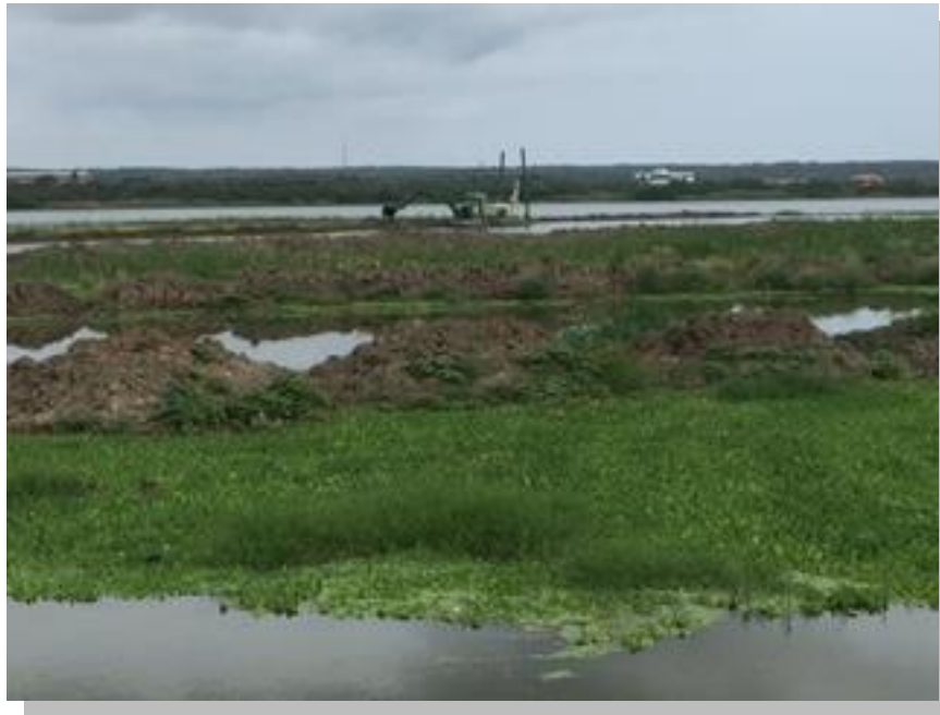
Equipos utilizados para el dragado.
