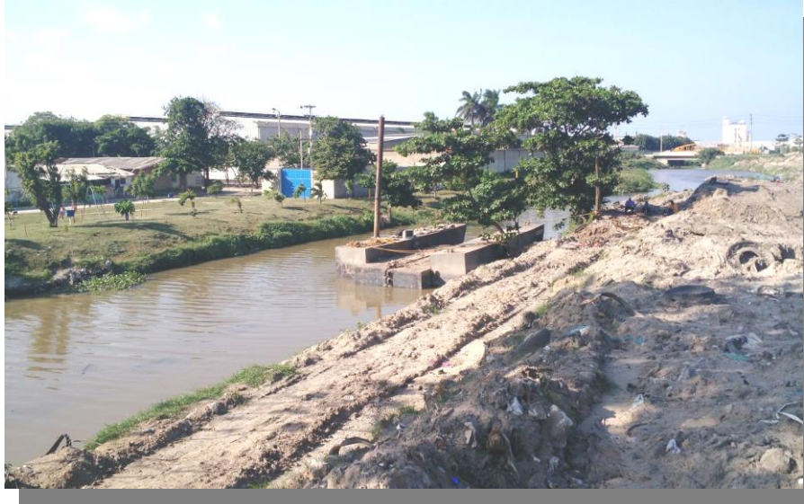
Aspecto final del caño Ahuyama luego del dragado
