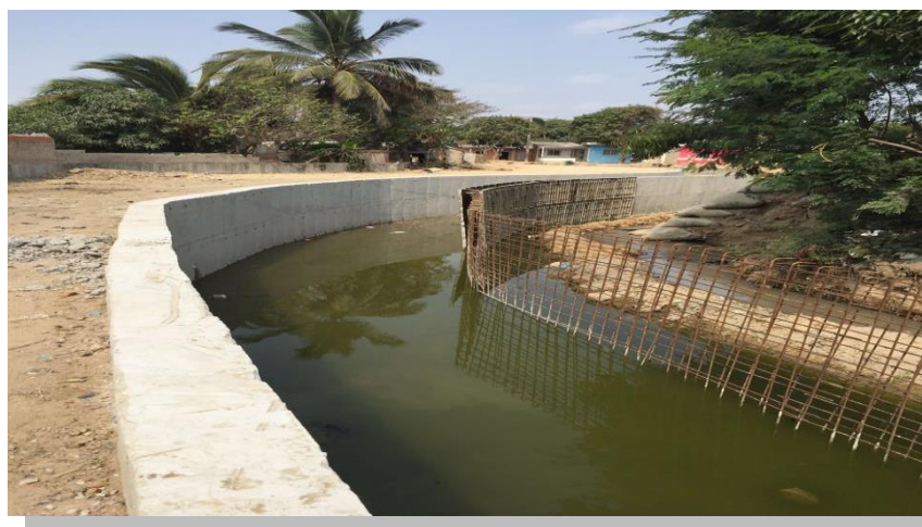
Construcción del Canal en concreto reforzado del arroyo el Salao.
