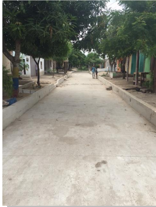
Vías Canales finalizadas
