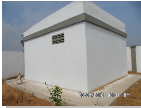
Fachada externa de la caseta con acabados
