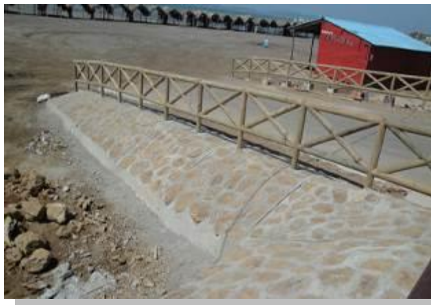
Construcción Enrocado Rampas de acceso K1+200.
