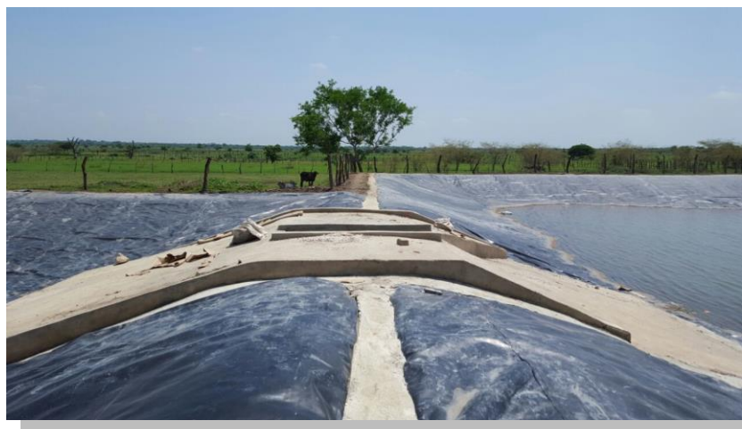
Actividades de instalación de geomembrana en el primer y segundo módulo.
