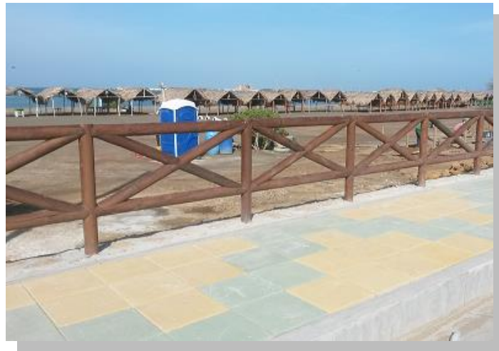
Instalación Loseta Andén
