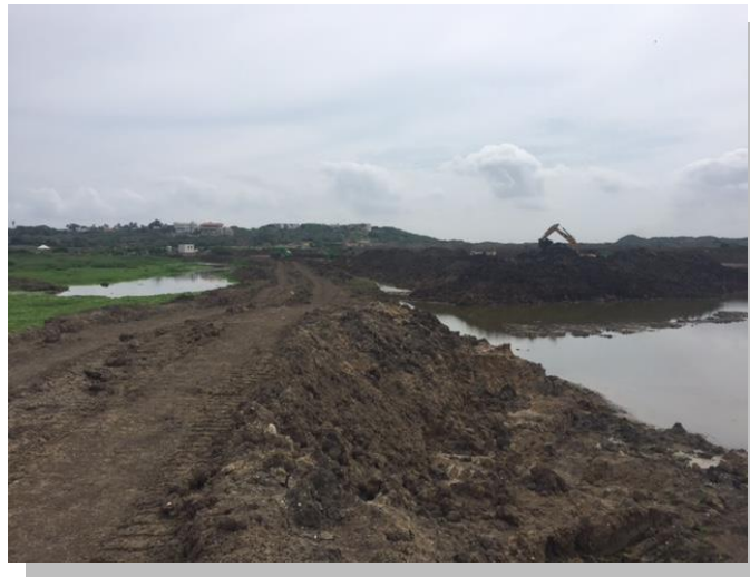
Construcción de piscinas para el depósito de sedimentos.
