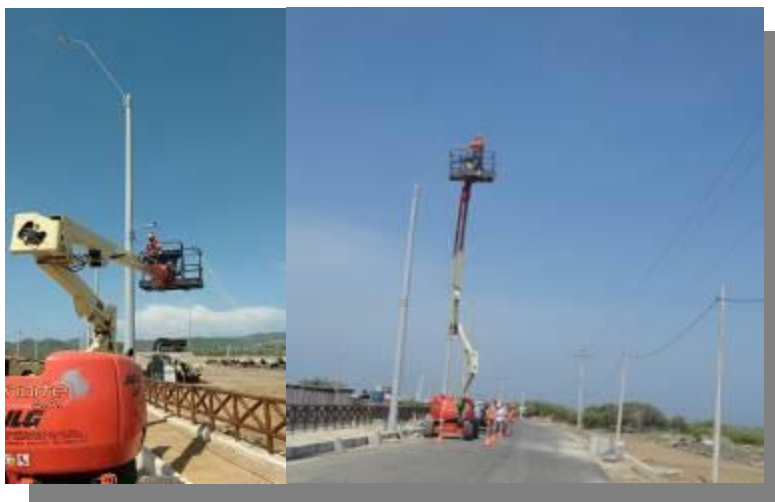
Instalación de Luminarias K0+770 a K0+910
