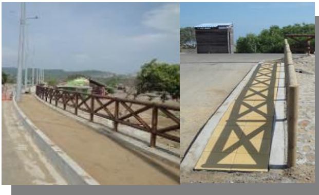
Bordillo cuneta y bordillo de confinamiento Vía y rampa de acceso
